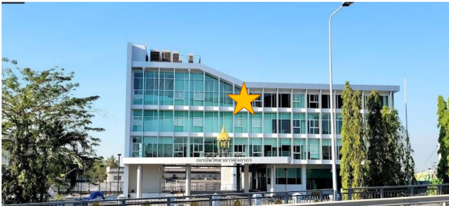
อาคารศูนย์ฝึกอบรม สถาบันวิทยากรคุลภากร สะพานกรุงเทพ
