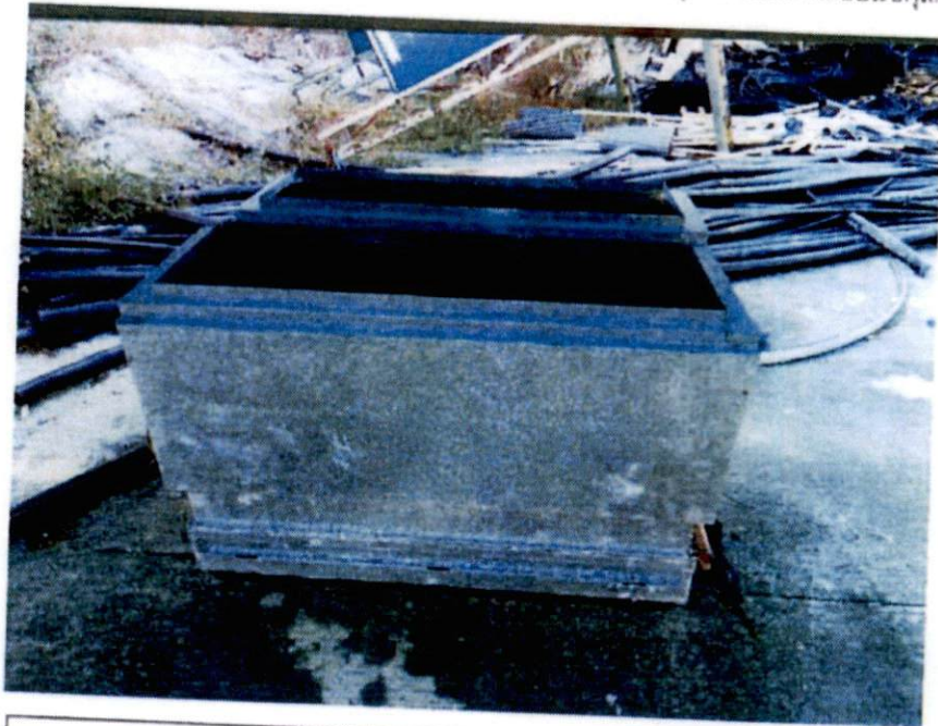
รูปที่ 17 สภาพเครื่องปรับอากาศที่รื้อย้าย ชุดที่ 3-4
