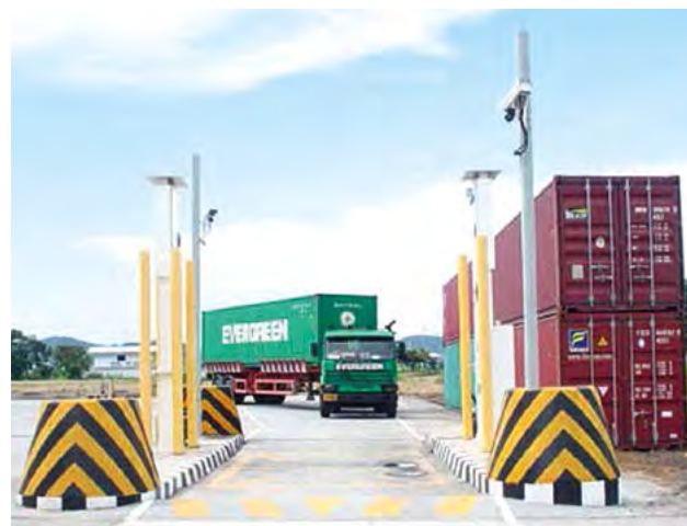
ภาพแสดงสถานีตรวจสอบกัมมันตรังสีขั้นแรก (Primary Station) ตามโครงการ MI
